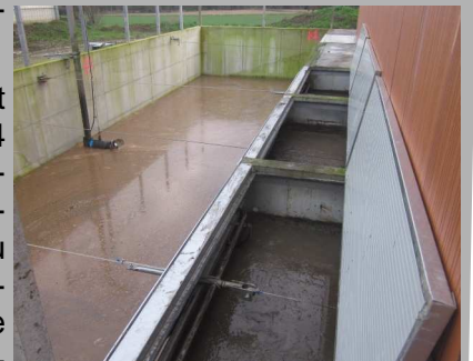
Raclage sur câble
