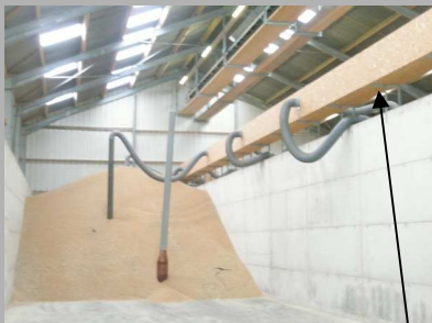
Gaine centralisée en dépression, avec cannes d'aspiration
