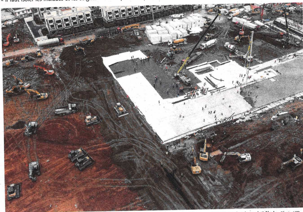
Des centaines d'ouvriers travaillent, depuis vendredi, à la construction du nouvel hôpital de Wuhan, qui doit être achevé pour le 3 février. Photo AFP
