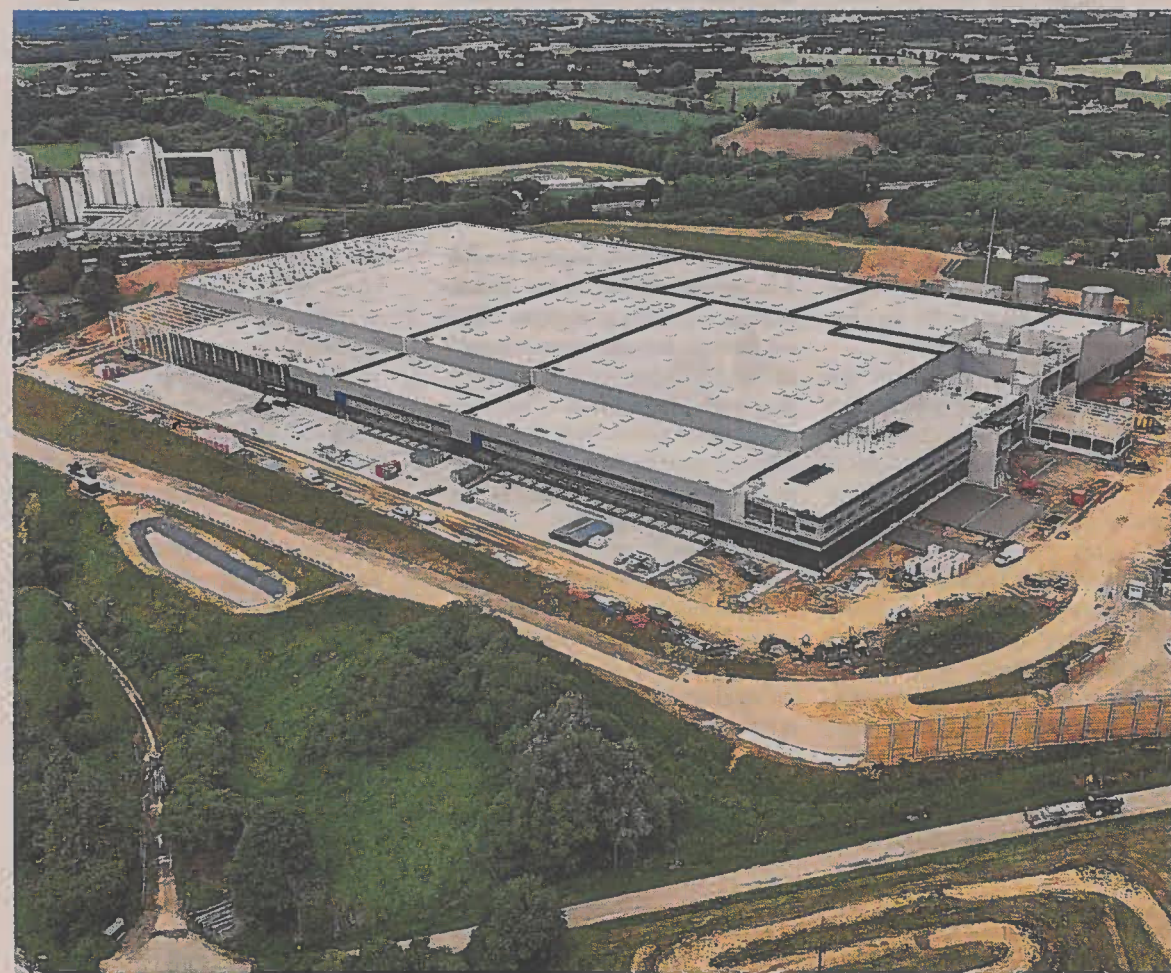
La nouvelle plateforme logistique de la marque de grande distribution Lidl, actuellement en construction dans la zone de Kertédavant à Châtelaudren. Photo Lionel Le Saux
