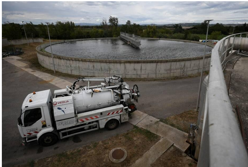
Une usine de traitement des eaux usées à Narbonne, dans le sud de la France, le 18 août 2022. Photo d'illustration. | VALENTINE CHAPUIS / AFP
