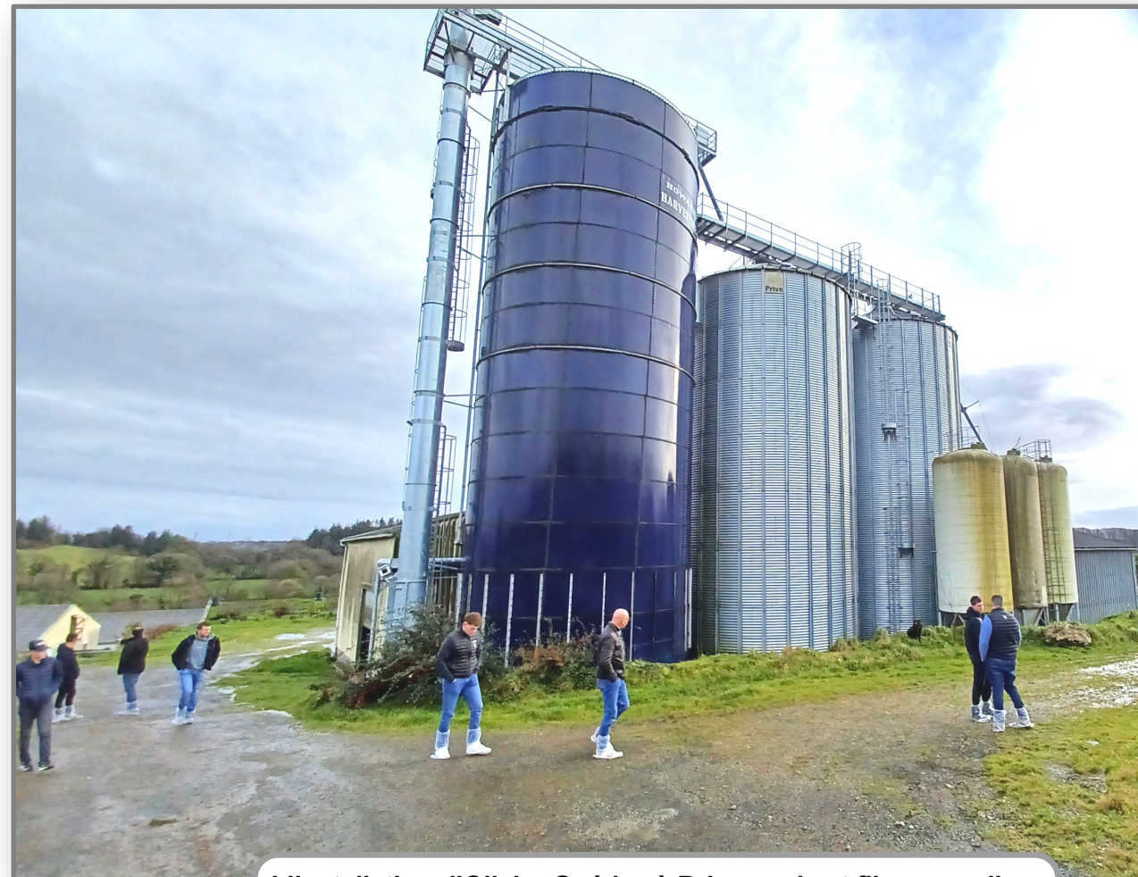
L'installation d'Olivier Guédes à Briec : soja et fibres en silos polyester extérieurs, orge-blé en cellules, maïs en silo tour.
