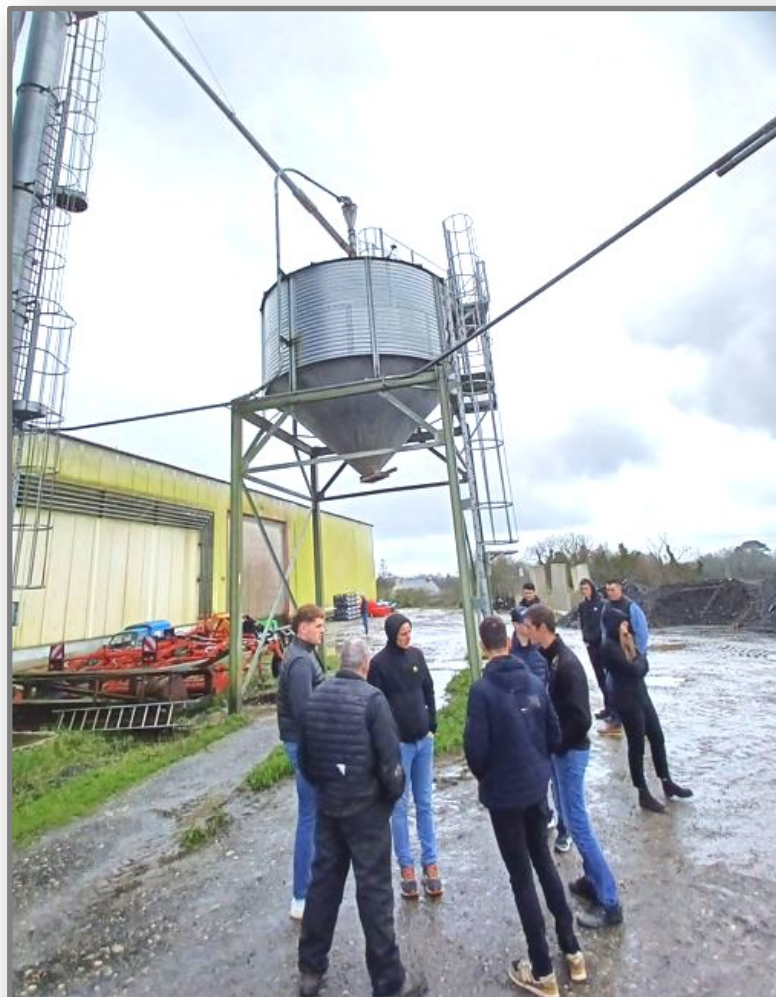
Un silo de chargement pour les sites volaille extérieurs
